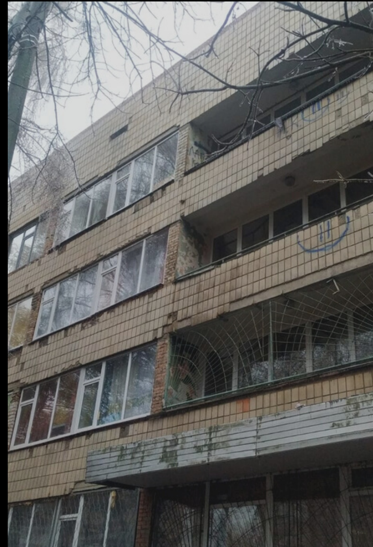
Підготовка до заміни вікон у гуртожитку. Актуальний вигляд.
