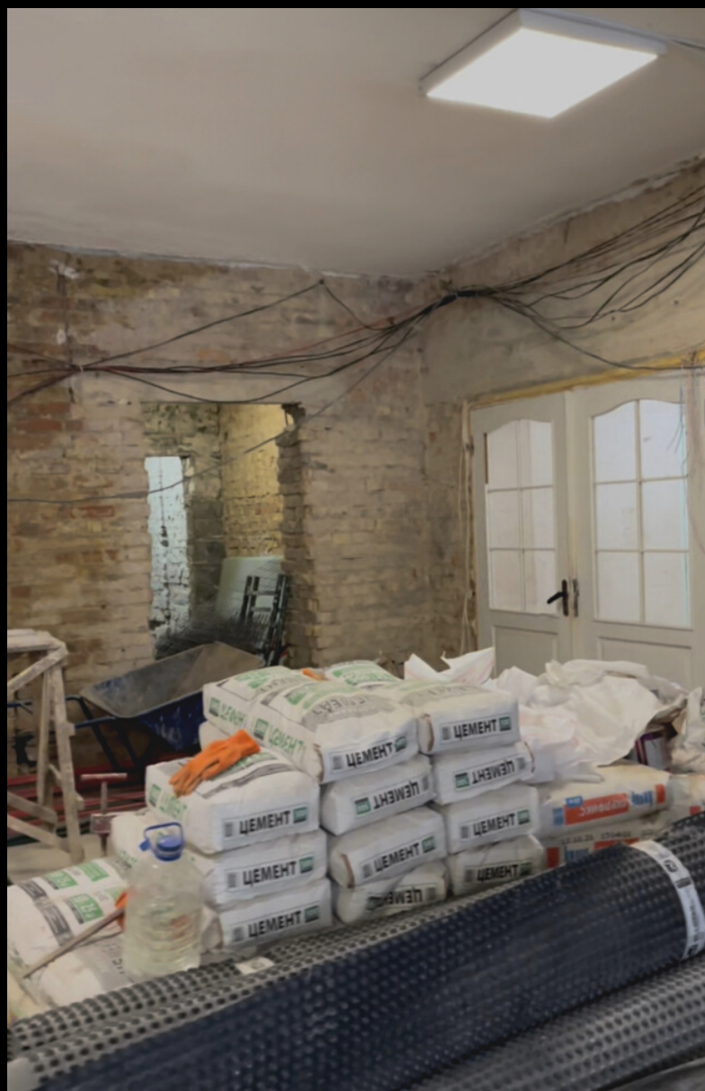
Підготовка до нанесення штукатурки в гуртожитку
