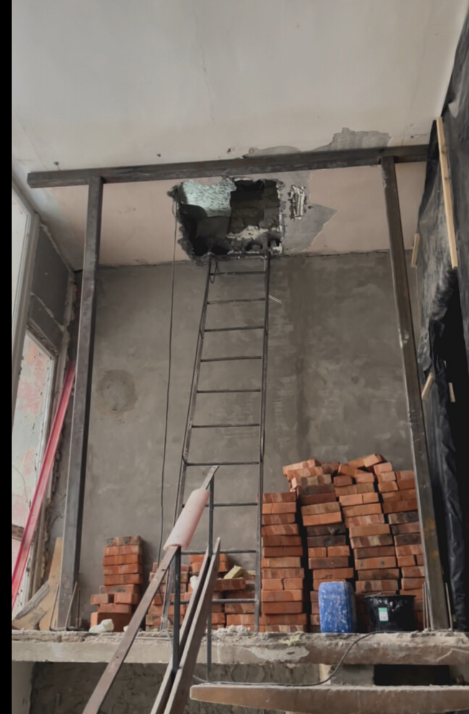
Східна клітина гуртожитку під час ремонту
