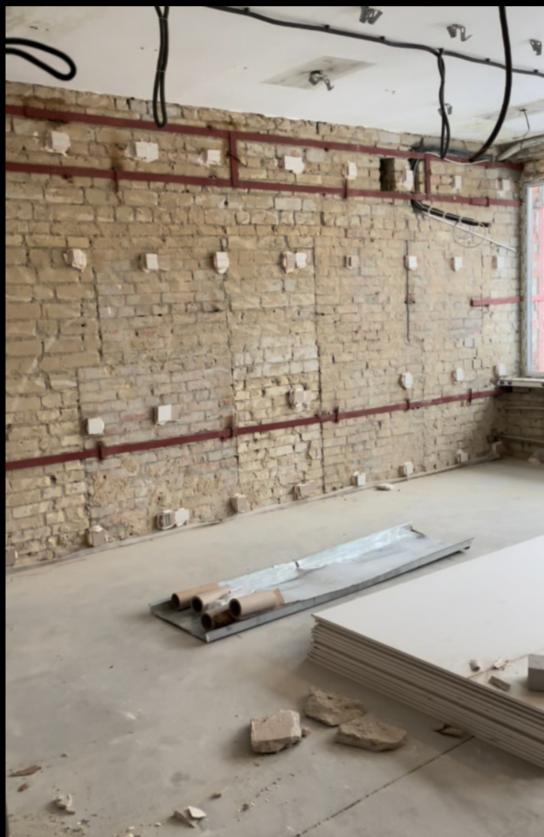
Процес облаштування стін гіпсокартонними плитами
